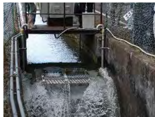
用水路に設置された小さな水力発電機 (栃木県宇都宮市)
