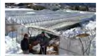
雪の重さでこわれた、いちごなどのビニールハウス(群馬県東吾妻町 2014年2月)
